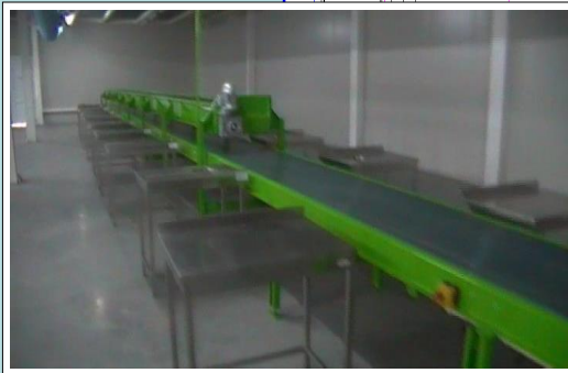
Общий вид смонтированной линии
